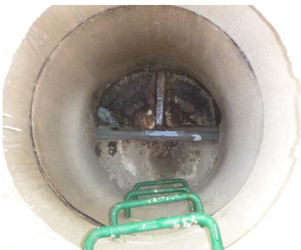
Réseau en amont des évacuations du supermarché Présence légère de graisses (effluents boulangerie)
