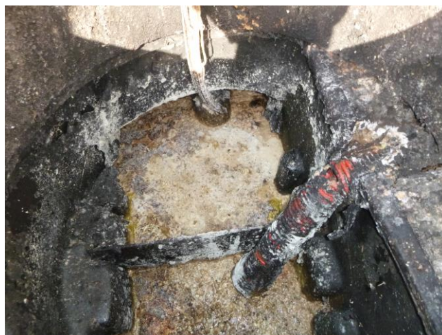
Vue sur l'intérieur du bac dégraisseur
